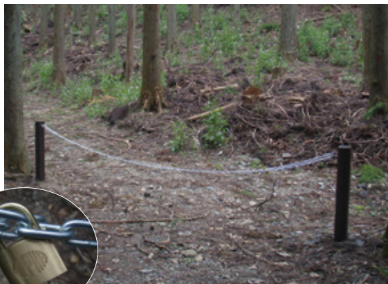
▲ ゲート設置完了
